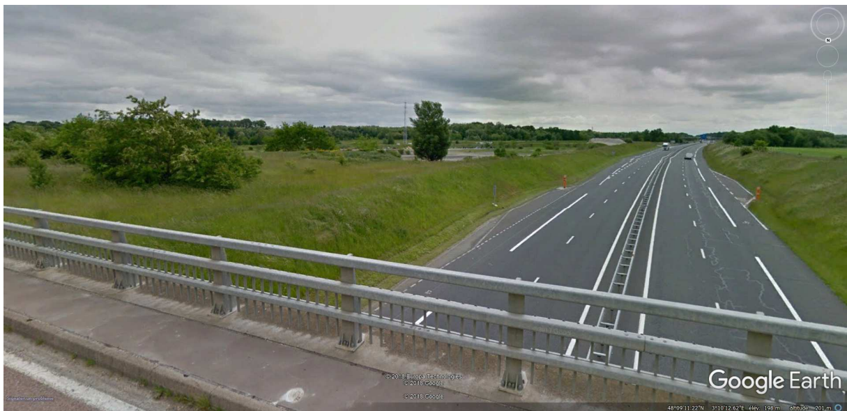
Figure 22 : Vue sur la plateforme depuis le pont de la RD369
